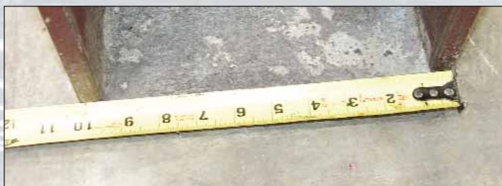
Pisos elevados re-engenhados da ResinDek requerem apenas colunas de 25 cm
