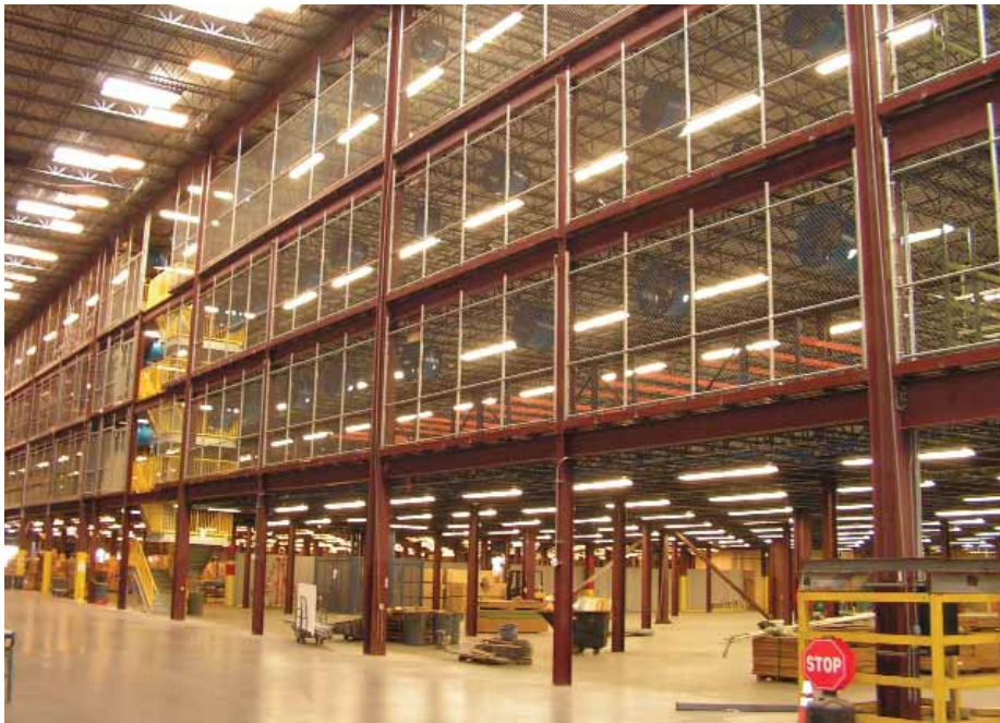
Plataformas de piso elevado de concreto exigem grandes quantidades de aço
