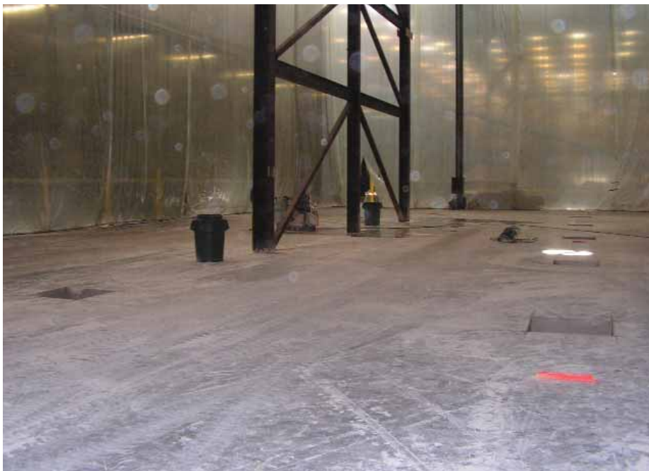
Preparo para a instalação dos painéis re-engenhados ResinDek ® Instalação de piso elevado nas instalações de distribuidor de artigos esportivos no Texas
